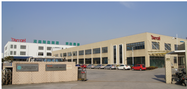
泰東機械 上海工場 泰東機械第一、二工場
